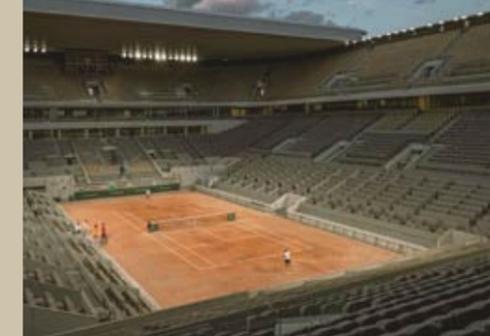
Die in das mobile Dach integrierte Beleuchtung ermöglicht nun auch die abendliche Austragung von Tennisturnieren auf dem Center Court.
