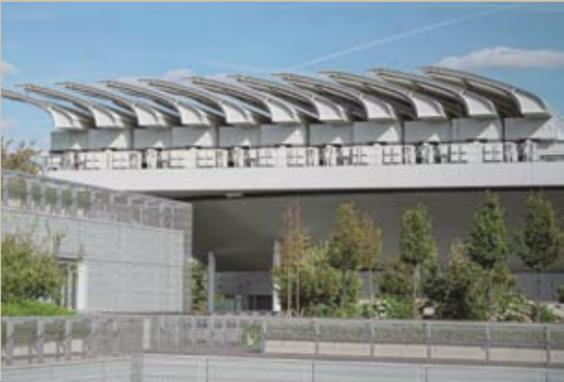
Die Dachkonstruktion des Court Philippe-Chatrier besteht aus 11 Flügeln, die sich bei Niederschlägen in nur 15 Minuten zu einem schützenden Dach ausfahren lassen.
