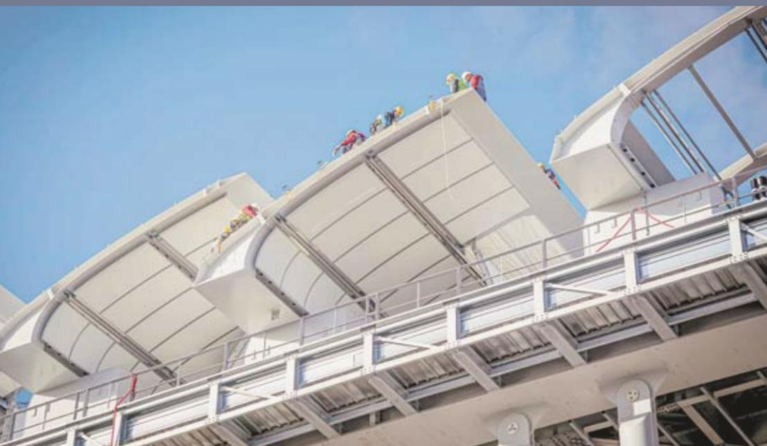
Jeder der insgesamt 11 Dachflügel des Center Court wurde auf der Innen- und Außenseite mit PVC-beschichteten Membranen bezogen.
