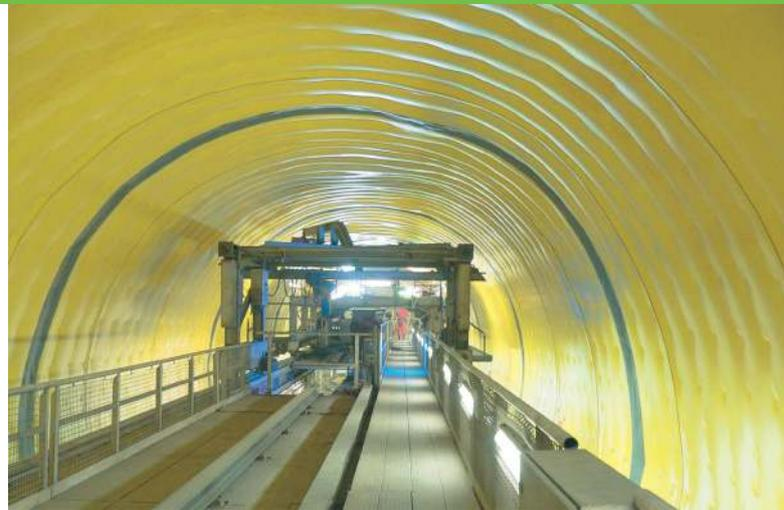
Härtetest im Gotthard-Basistunnel: Die Auskleidung der Tunnelröhren aus PVC-Dichtungsbahnen muss den extremen klimatischen Bedingungen unter Tage bis zu 100 Jahre lang standhalten. Foto: Sika Service AG
