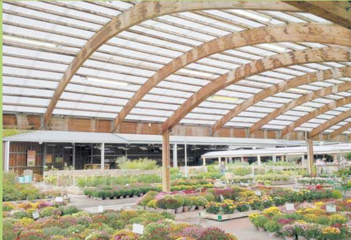
Biaxial gereckte PVC-Platten lassen viel Licht in Gebäude, sparen dadurch Energie und sind sehr witterungsbeständig. Foto: RENOLIT SE
